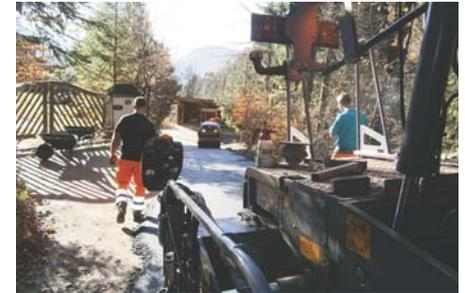
saniert. Der desolate Unterbau wurde erneuert, Engstellen beseitigt und eine neue Asphaltsschicht aufgetragen.
