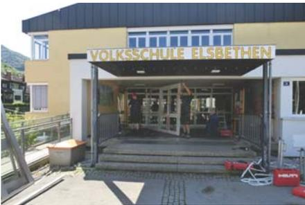
Fluchttüren mit beidseits einem Fixglaselement auf. Der Einbau erfolgte im August 2013 und gewährleistet mit der hofseitigen Notstiege größtmögliche Sicherheit für Schüler und Lehrer.
