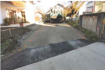
weberweg im Bereich der Firma Anzenbacher wurde im November 2013 asphaltiert. Die einspurige Verbindungsstraße entwässert in zwei Sickerschächte. Die Asphaltbreite beträgt ca. 3,0 m.
