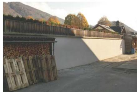
konnte im September 2013 saniert werden. Nachdem Frostschäden die Standsicherheit beeinträchtigten führte die Baufirma Waldmann aus Elsbethen die notwendigen Bauarbeiten durch.
