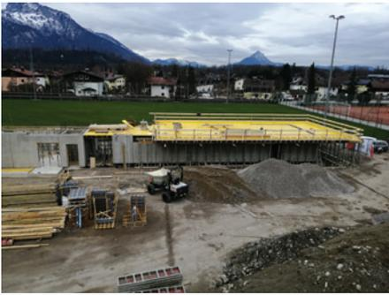
Obergeschoss des USK-Heimes und die ESV-Stockhalle in Hybridbauweise (d.h. Stahlbetonskelettbau kombiniert mit Vollholzelementen) ausgeführt werden.
