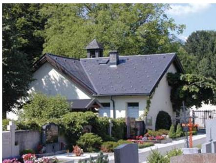
alten Faserzementplatten wurden zur Gänze abgetragen und auf einem neuen Unterdach mit einer Eternit-Doppeldeckung ausgetauscht. Die undichten Dachrinnen und die verrosteten Schneerechen wurden durch verzinktes, farbbeschichtetes Stahlblech ersetzt.
