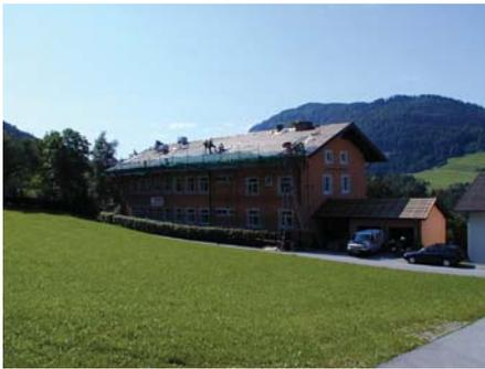
die Dachsanierung abgeschlossen. 765 m<sup>2</sup> Dachpappe und Eternit-Faserzementplatten in Doppeldeckung, 95 m Schneerechen, 100 m Dachrinnen sowie 65 m Ablaufrohre wurden entfernt und erneuert. In Summe wurden für Dachdecker- und Spenglerarbeiten und die Erneuerung des Blitzschutzes 72.400,- ausgeben.
