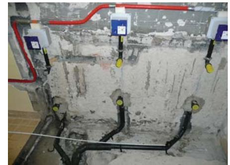
Pissoirs im Turnhallentrakt an der Reihe. Unser Gemeindebauhof erledigte die Demontage und den Abbruch der Fliesen. Anschließend wurde die ganze Anlage vom Wasseranschluss über die Abläufe bis zu den Wandurinalen mit der elektrischen Steuerung von der Firma Zutz erneuert. Die Fliesenlegerarbeiten führte die Firma Ebner durch.
