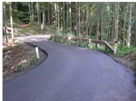
Bei der Gfallsstraße wurde die Straßendecke an mehreren Stellen durch das Aufbringen einer neuen Asphaltsschicht saniert.
