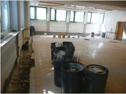
Im Mehrzweckraum der Volksschule Elsbethen ist ein Wasserschaden aufgetreten. Bei der Suche nach der Schadensursache wurde eine Fuge zwischen aufgehendem Mauerwerk und Bodenplatte als Ursache festgestellt.
