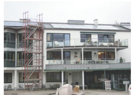
dem Dach des Seniorenwohnheimes waren undicht und mussten ausgetauscht werden. Unter Leitung der Heimat Österreich und mit Hilfe der Firma Sonnenkraft wurde die Solaranlage aus dem Jahr 1999 zur Gänze abgebaut und erneuert. Damit liefern 20 Kollektoren mit insgesamt 50 m<sup>2</sup> Fläche Heißwasser für Seniorenwohnhaus und Gemeindeamt.
